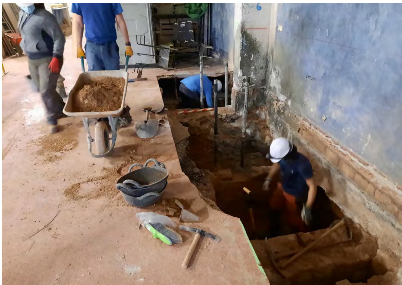
Imatge de la realització manual de les excavacions de les refonamentacions de la Zona Interior Colom Dreta. 15/FEB/2021 (E. Píriz).
