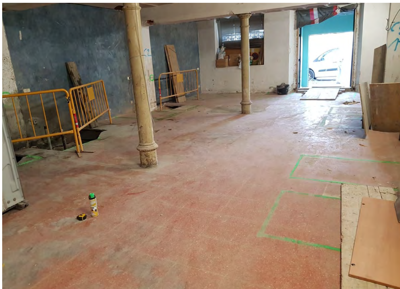
Imatge general de l'estat inicial del Sector Interior Colom Dret, previ a la nostra intervenció. Es poden veure els fonaments iniciats amb els micropilons clavats. 27/GEN/2021 (E. Píriz).
