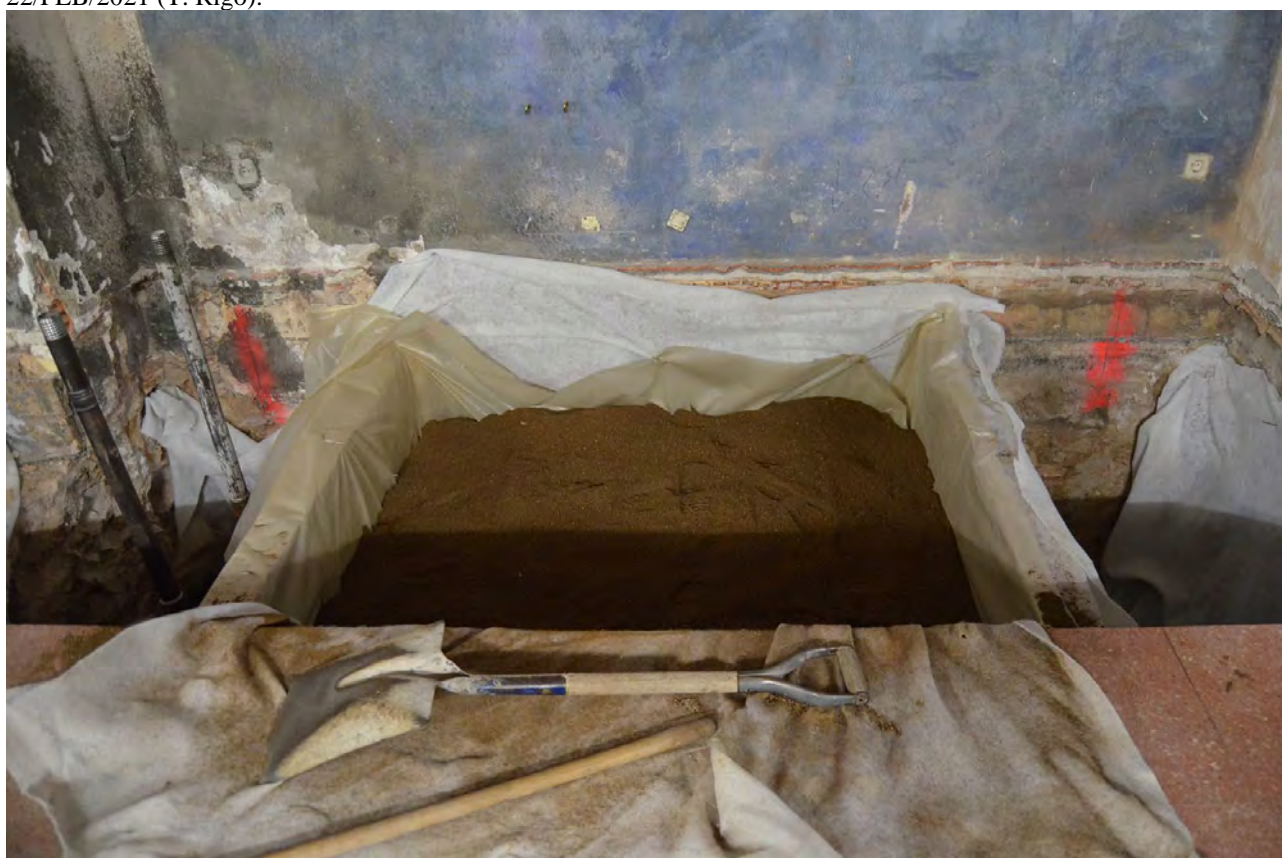
Detall de la protecció de les estructures localitzades al Sector Interior Colom Dret amb el geotèxtil i la làmina plàstica. 22/FEB/2021 (T. Rigo).
