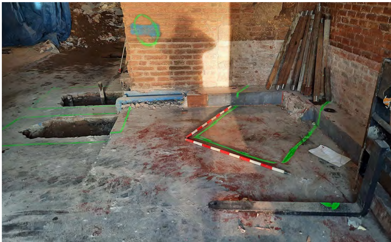
Imatge general de l'estat inicial del Sector Interior Colom Esquerre, previ a la nostra intervenció. Es poden veure els fonaments iniciats amb els micropilons clavats i runa al fons procedent dels enderroc de l'obra.28/GEN/2021(E. Píriz).
