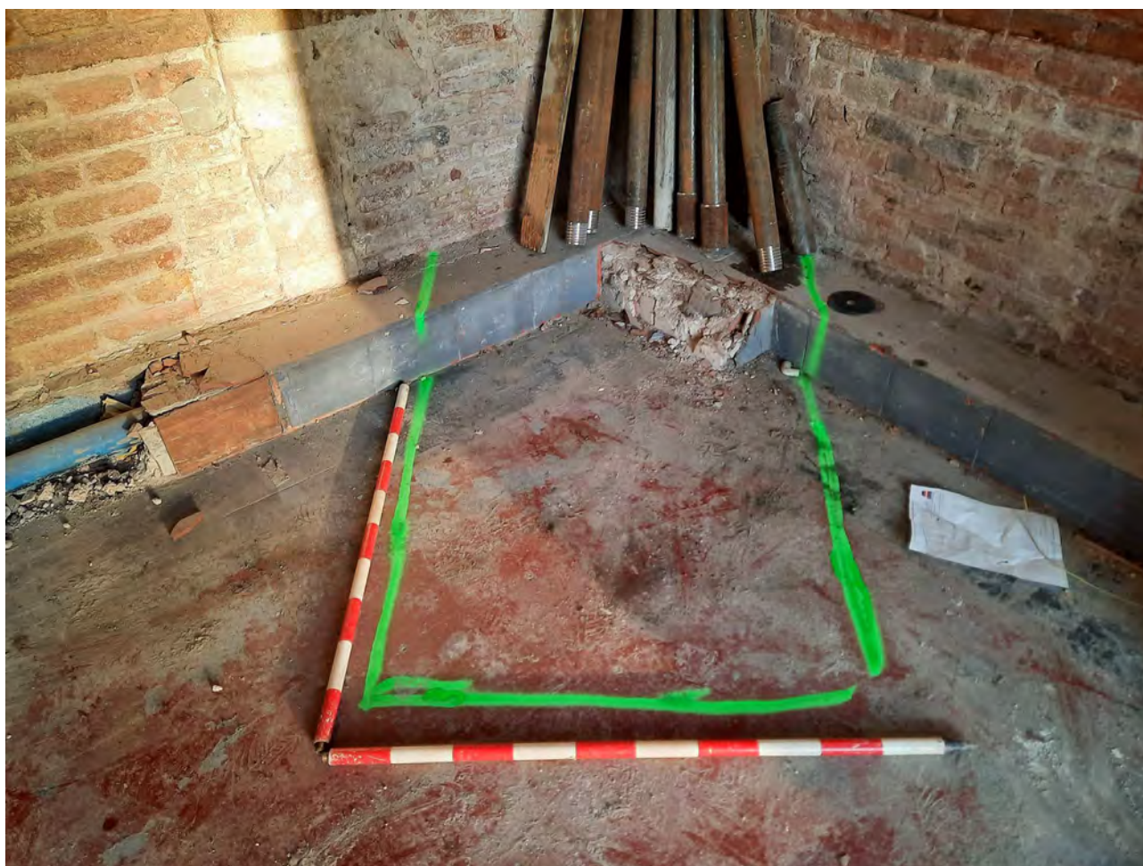
Imatge de l'estat inicial del sondeig C situat al Sector Interior Colom Esquerre, on es pot veure el paviment UE-117 format per peces de morter de color blau armades pintades de color granat. 28/GEN/2021 (E. Píriz).
