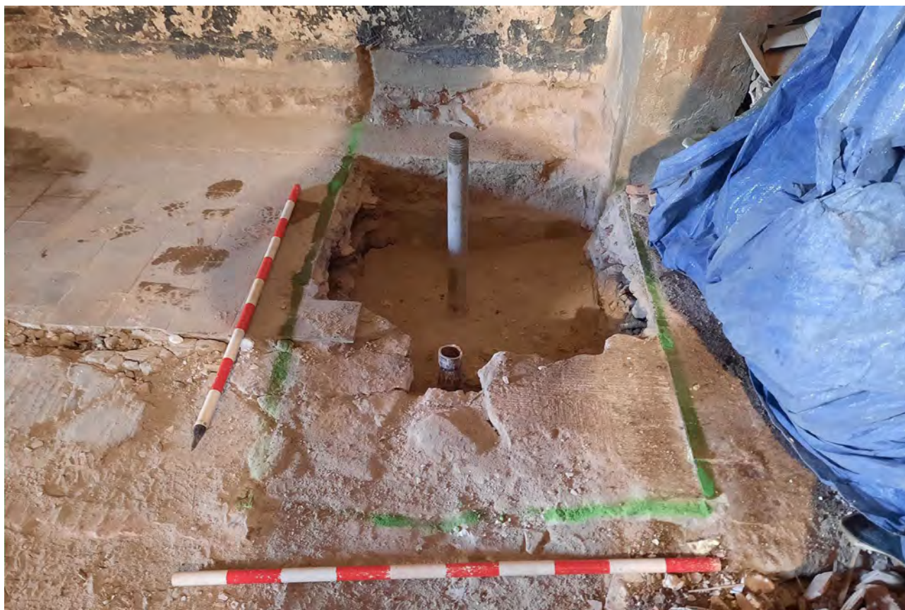
Fotografia dels sondejos H i J amb l'encepat excavat, els micropilons clavats i el morter de ciment de les injeccions reblint l'excavació dels enceps. El sondeig J està completament cobert de runa de l'obra. 28/GEN/2021 (E. Píriz).
