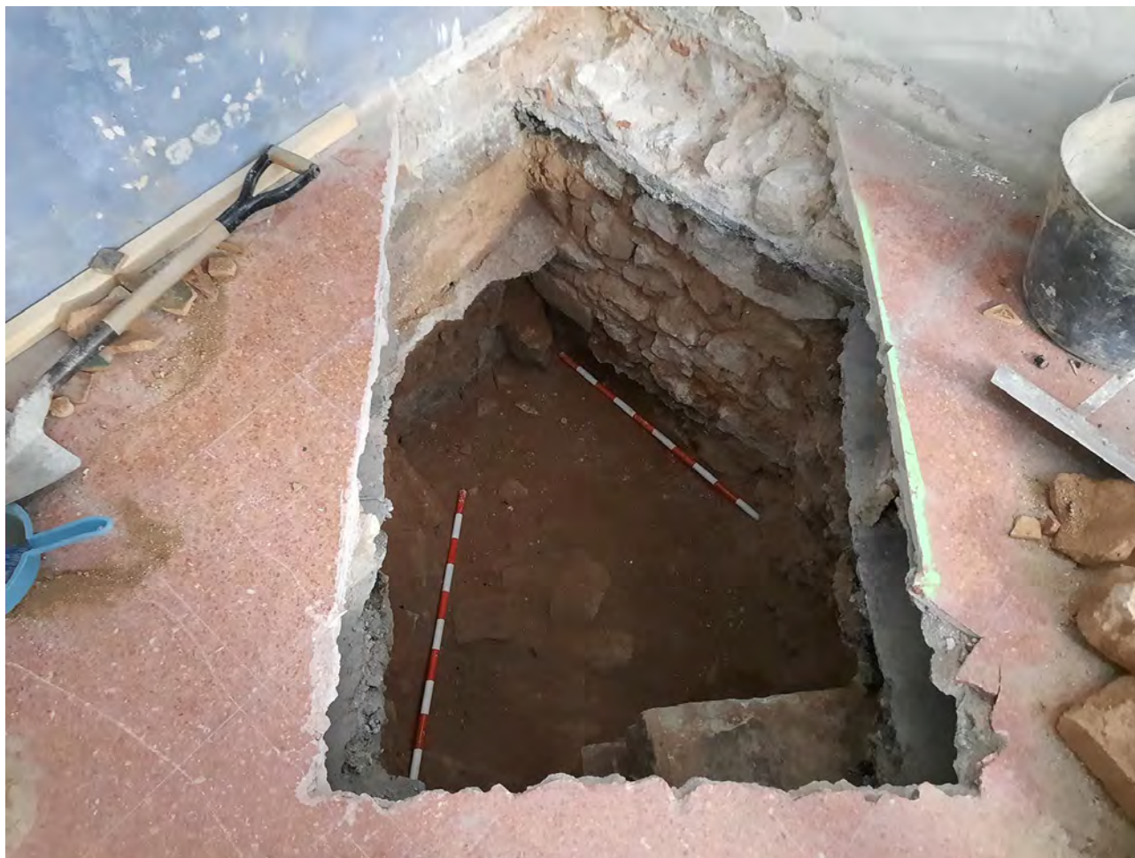
Imatge del sondeig 3 finalitzat on es pot veure l'estrat de runa UE-107 que no va ser exhaurit i l'estructura de fonamentació UE-15 de la façana. 11/FEB/2021 (E. Píriz).
