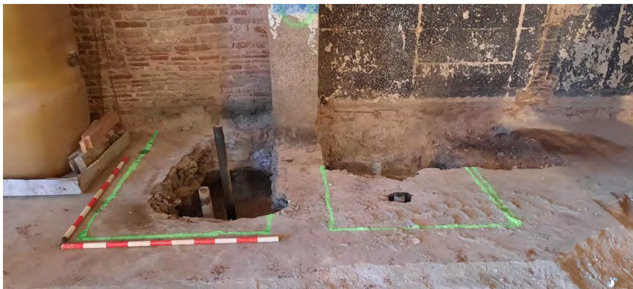
Fotografia dels sondejos D i F amb l'encepat excavat, els micropilons clavats i el morter de ciment de les injeccions reblint l'excavació dels enceps. 28/GEN/2021 (E. Píriz).
