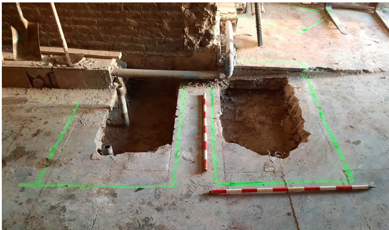
Fotografia dels sondejos E i G amb l'encepat excavat, els micropilons clavats i el morter de ciment de les injeccions reblint l'excavació dels enceps. 28/GEN/2021 (E. Píriz).
