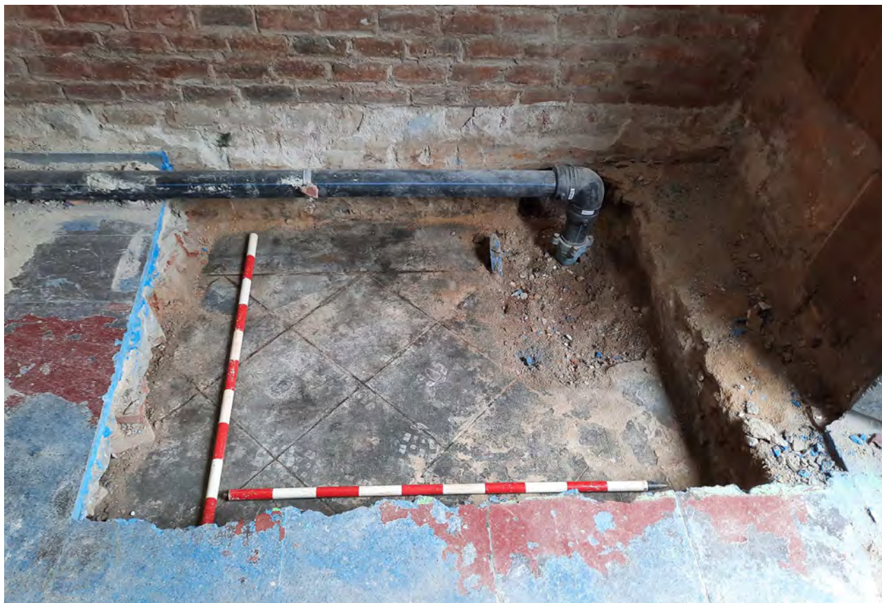
Detall del sondeig B, on es pot veure el paviment de morter de ciment Portland UE-102. També es veuen les estructures UE-10 façana, UE-15 fonament de la façana i UE-12 mur de tancament interior d'aquest àmbit. 8/FEB/2021 (E. Píriz).
