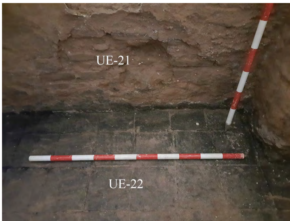
Detall de l'estat d'ennegriment del paviment UE-22 i de com el revestiment del mur UE-21 també està recremat a la seva part inferior. 19/FEB/2021 (E. Píriz).
