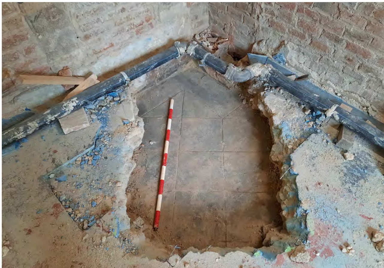
Detall del sondeig C, on es pot veure el paviment de morter de ciment Portland UE-102. També es veuen les estructures interiors UE-12 i UE-13. 8/FEB/2021 (E. Píriz).
