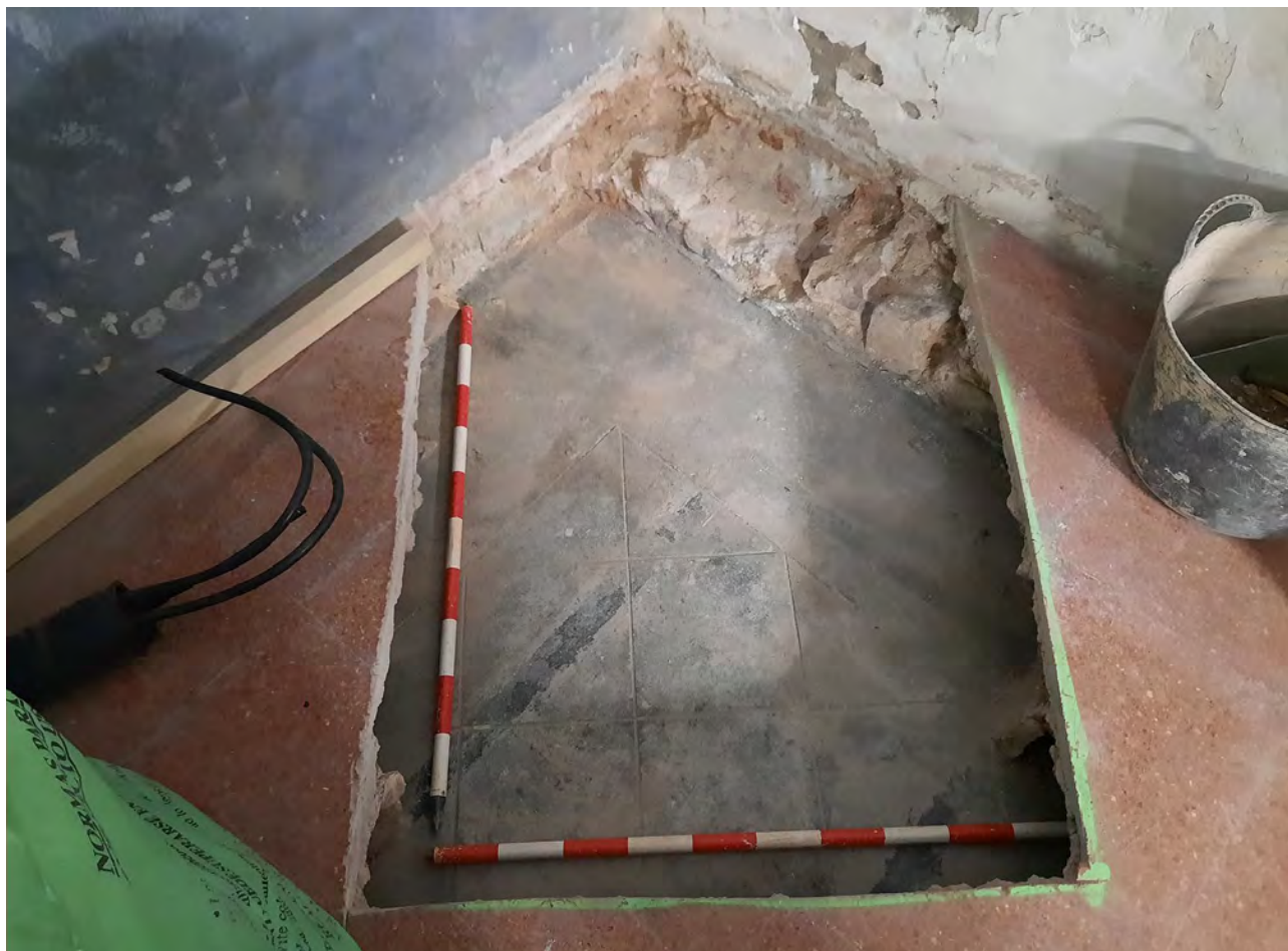
Detall del sondeig 3, on es pot veure el paviment UE-100, l'estructura d'envanets de sostremort UE-101 i el paviment de morter de ciment Portland UE-102. També es veu l'estructura UE-15 fonament de la façana. 8/FEB/2021 (E. Píriz).
