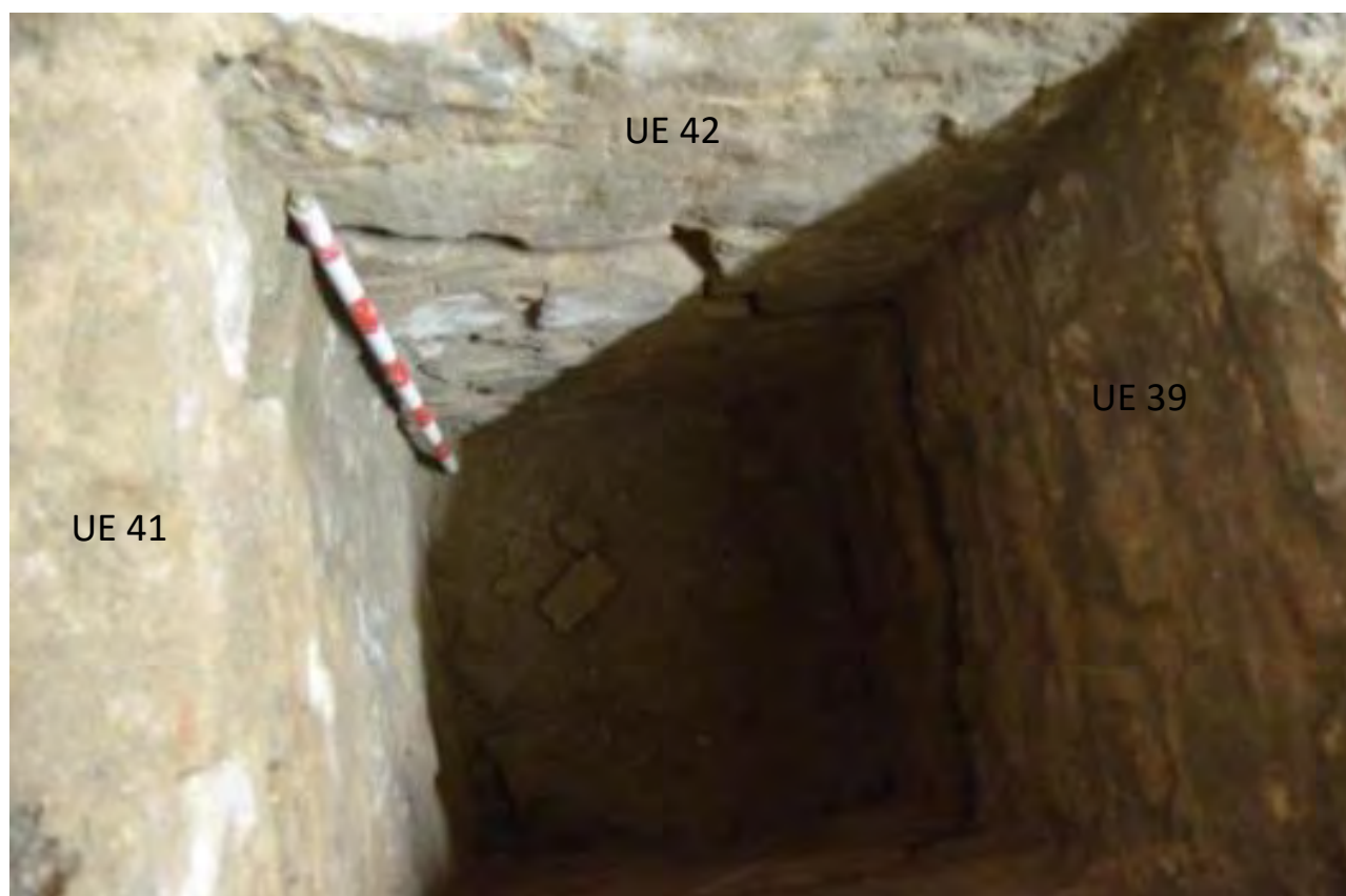
Interior de la fossa sèptica. (T. Rigo).
