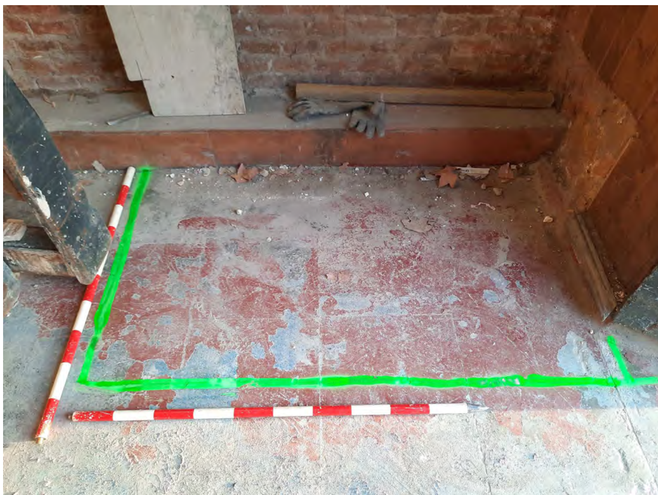
Imatge de l'estat inicial del sondeig B situat al Sector Interior Colom Esquerre, on es pot veure el paviment UE-117 format per peces de morter de color blau armades. 28/GEN/2021 (E. Píriz).
