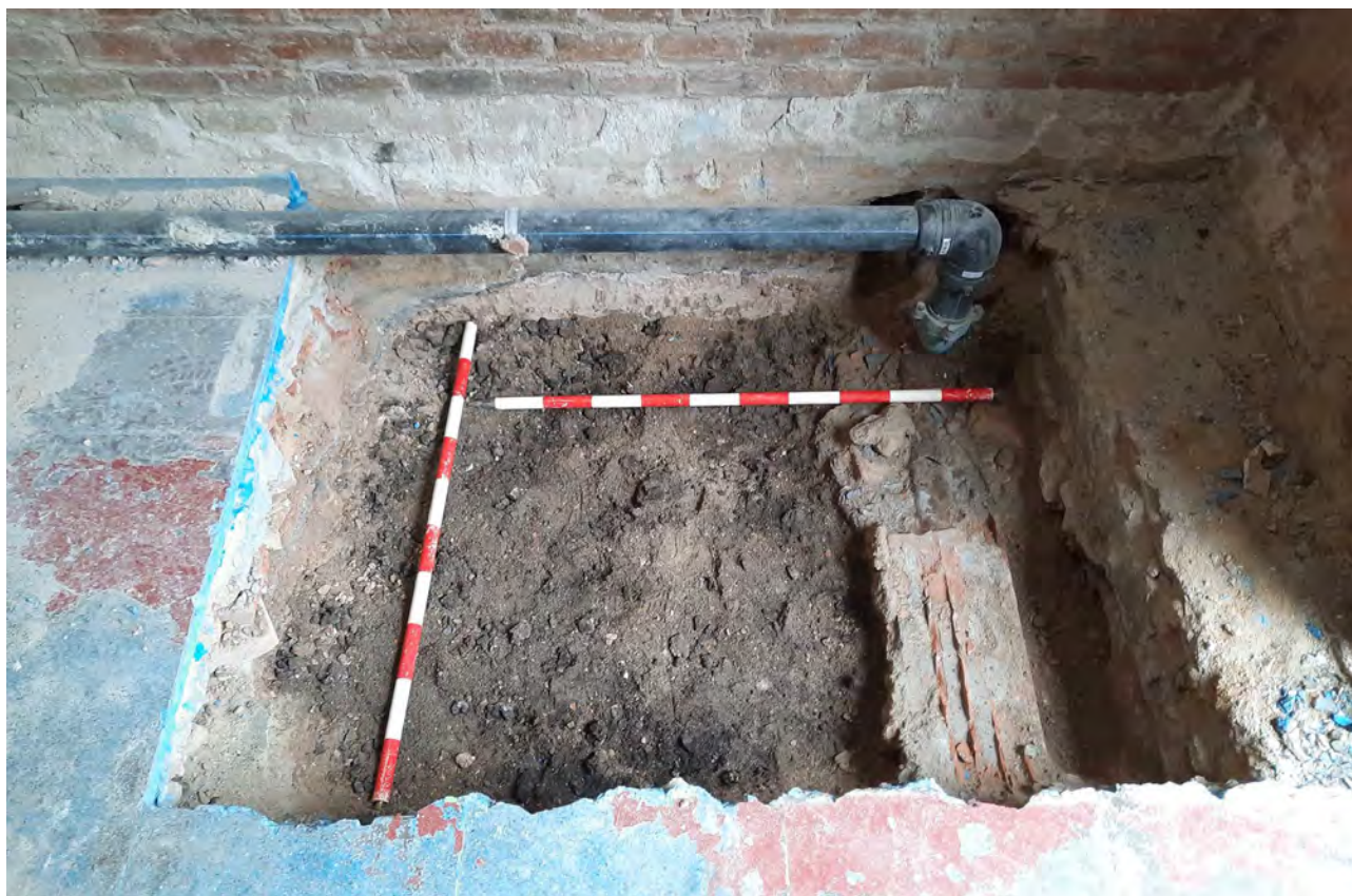
Foto del sondeig B un cop retirat el paviment UE-102 i la seva base UE-103. Es veu clarament l'estrat negre d'escòries UE-104 i la fonamentació UE-15 a la dreta de la imatge. 8/FEB/2021 (E. Píriz).
