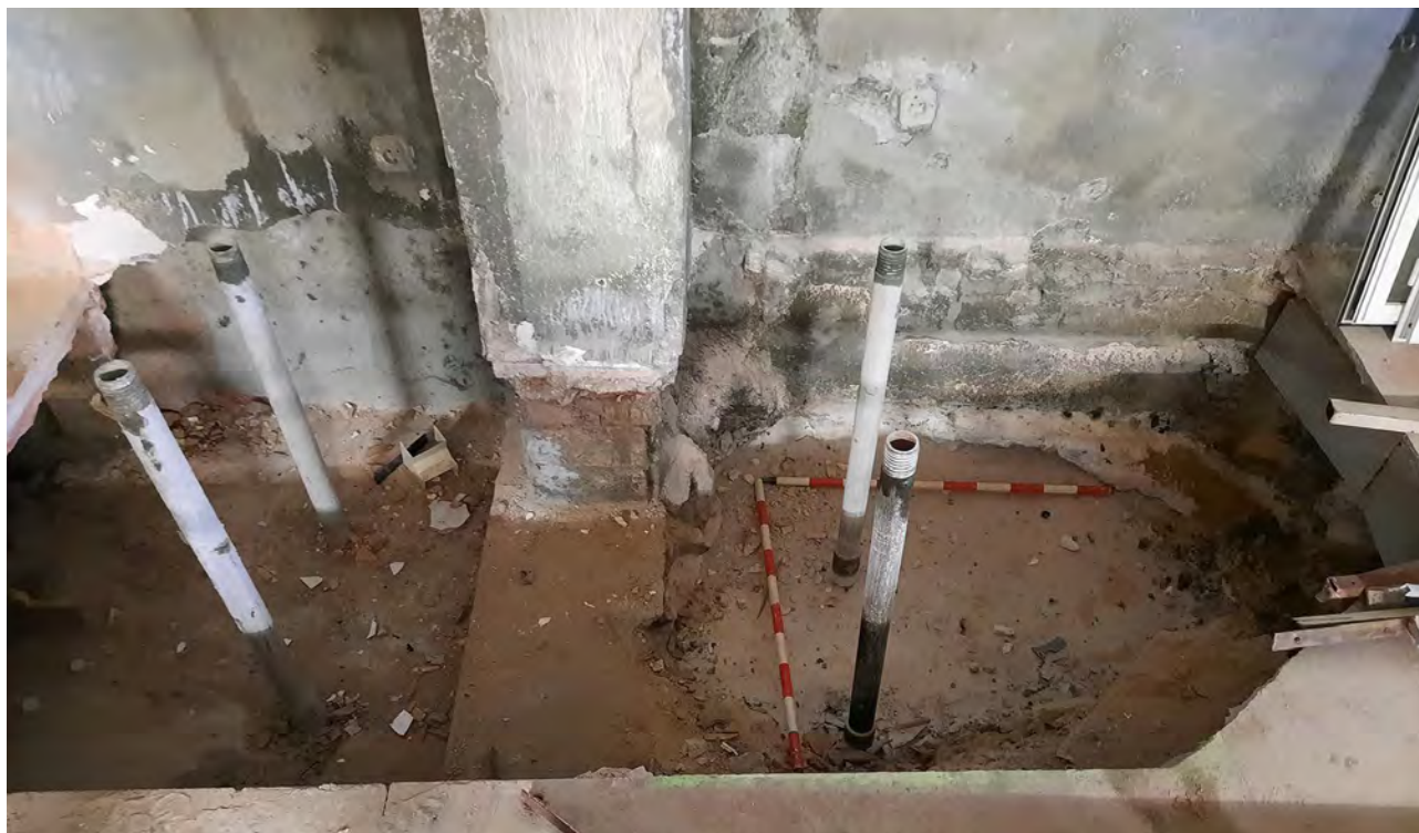
Imatge dels sondejos 9 i 11 un cop eliminat el paviment superficial UE-100 que es trobava entre ells. Es pot veure l'estat inicial després d'executar els micropilons. A la superfície el morter d'injecció. 8/FEB/2021 (E. Píriz).
