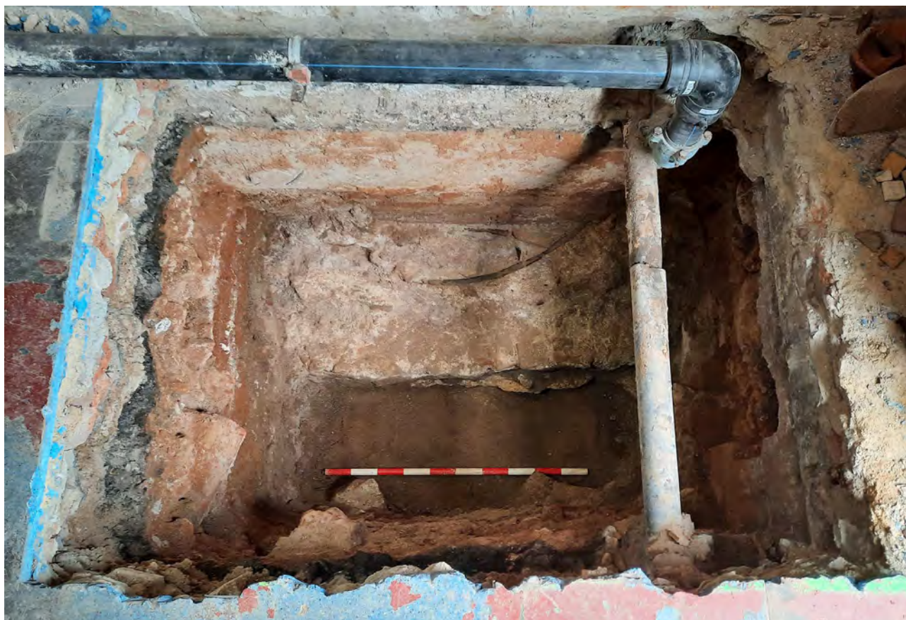
Imatge del sondeig B finalitzat on es pot veure l'estrat de sorres UE-124 i les estructures UE-120 fonamentació d'estructures de l'edifici de 1860, fonamentació UE-15 de la façana del passeig Colom. 9/FEB/2021 (E. Píriz).
