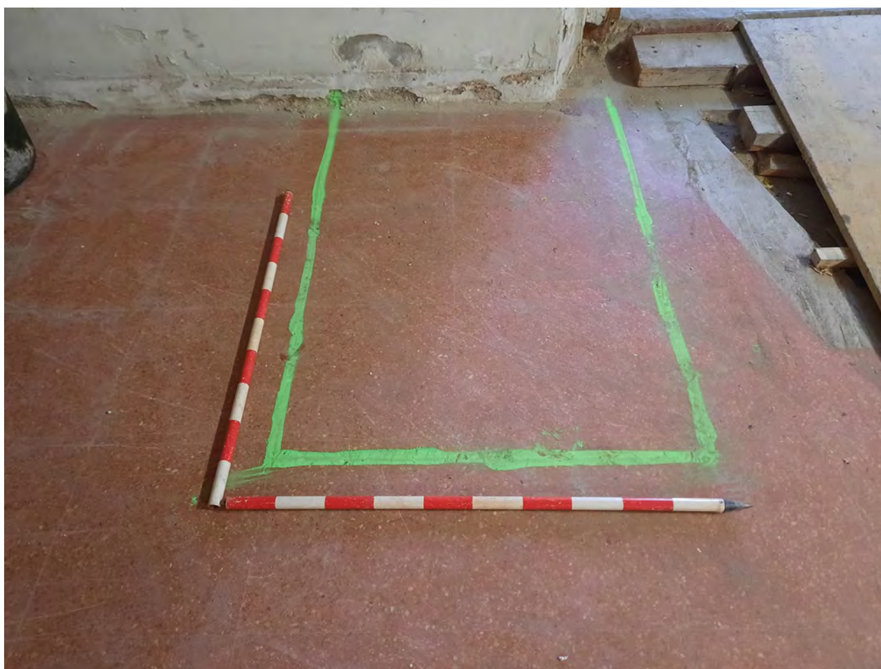
Imatge de l'estat inicial del sondeig 2 situat al Sector Interior Colom Dret, on es pot veure el paviment UE-100 format per rajoles de terratzo. 28/GEN/2021 (E. Píriz).
