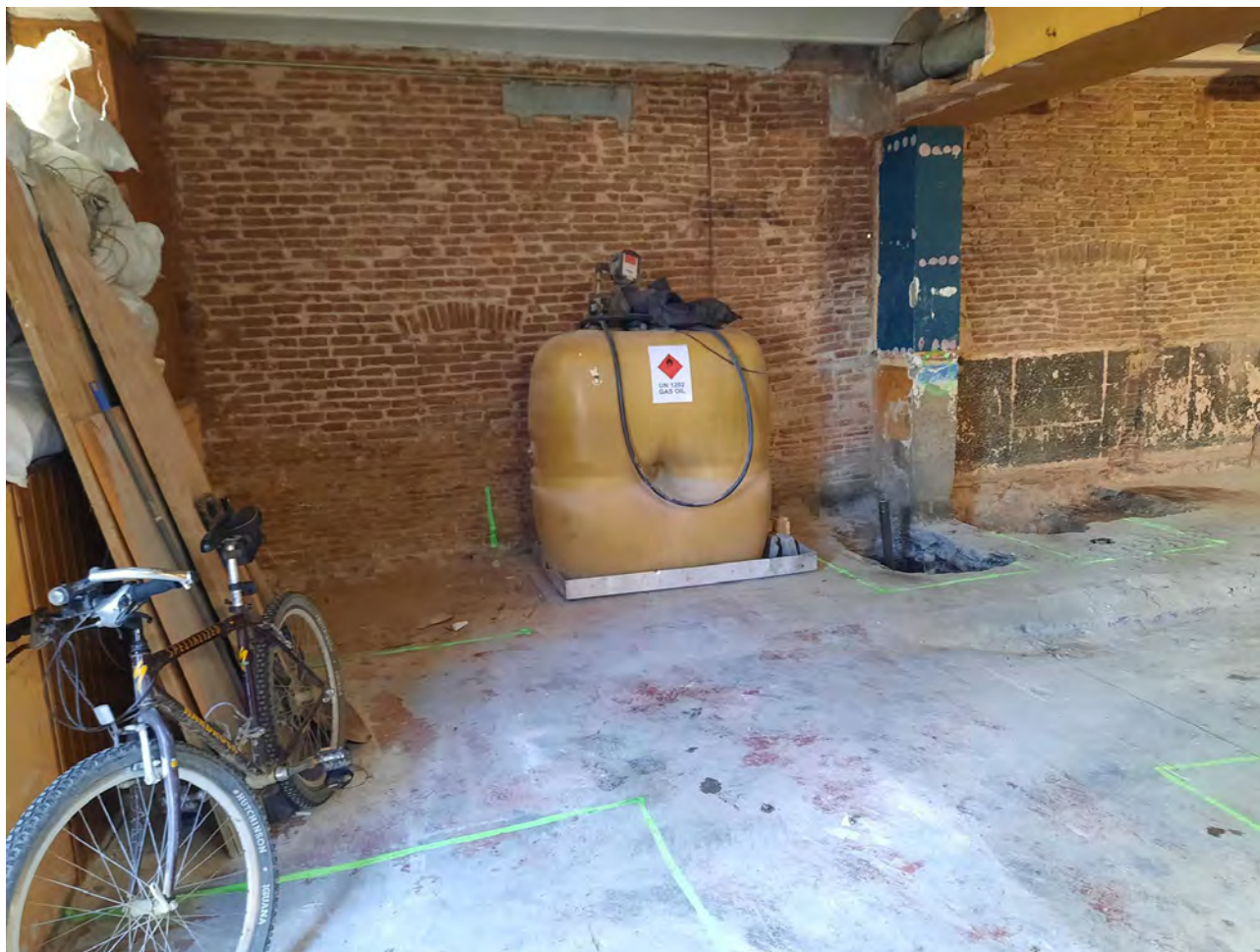
Imatge general de l'estat inicial del Sector Interior Colom Esquerre, previ a la nostra intervenció. Es poden veure els fonaments marcats a terra en verd i dos d'ells iniciats, un amb els micropilons clavats. 28/GEN/2021 (E. Píriz).
