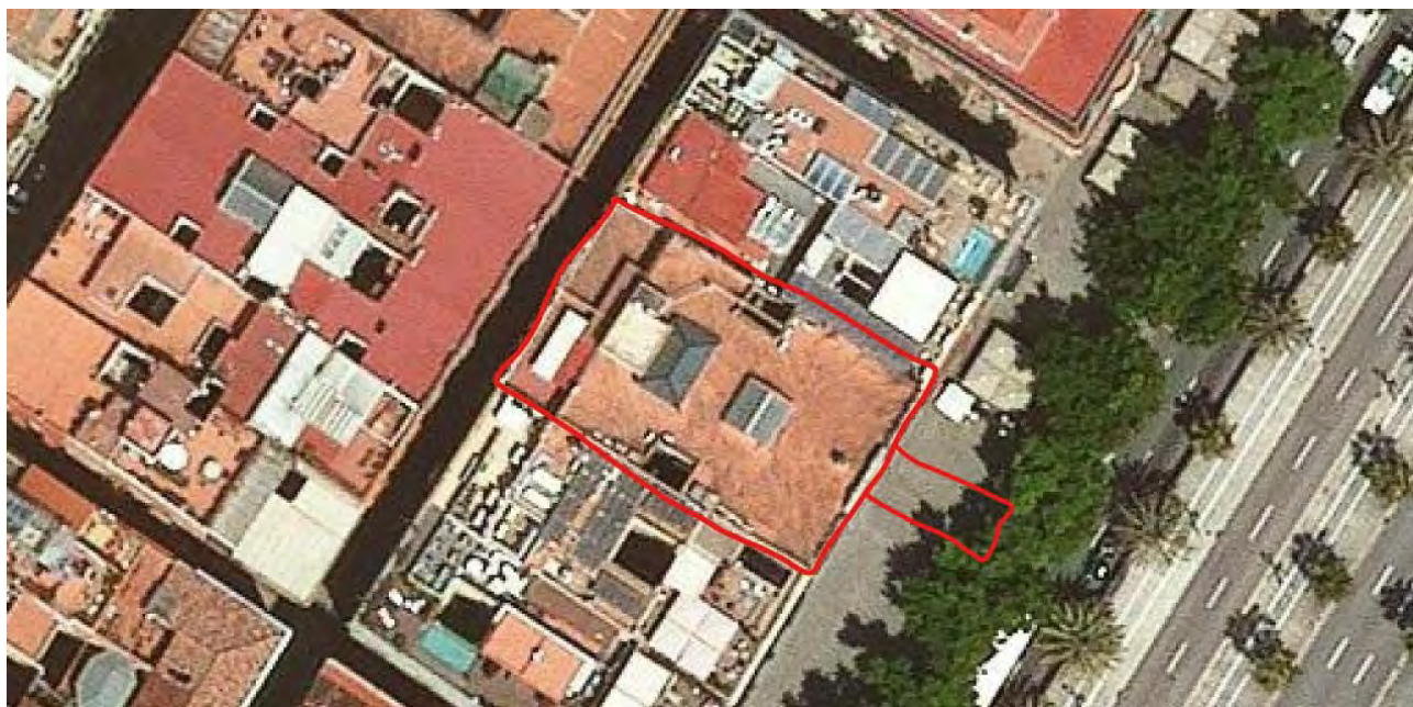
Imatge aèria de la coberta de l'edifici Condeminas. (Imatge obtinguda de la pàgina web de l'ICGC. 2021).
