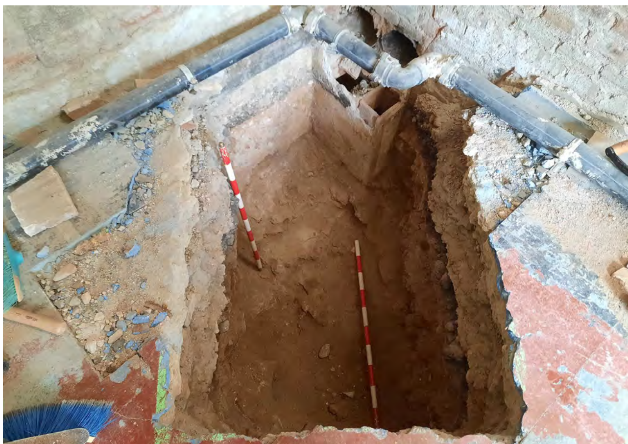
Imatge del sondeig C finalitzat on es pot veure l'estrat de sorres UE-124 i una estructura de canalitzacions UE-125 vinculades als mur UE-12 i UE-13 de la reforma de l'edifici de principis del segle XX. 12/FEB/2021 (E. Píriz).
