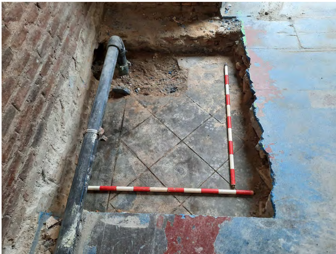
Detall del sondeig B on es pot veure el paviment continu de morter de ciment Portland UE-102. 8/FEB/2021 (E. Píriz).
