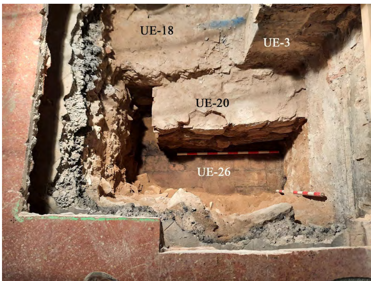
Detall del fonament UE-20 per reforçar el matxó UE-3. Es pot veure la seva relació amb el mur UE-18 que fa de riostra i amb el paviment UE-26 anterior a l'edifici de 1860. 15/FEB/2021 (E. Píriz).
