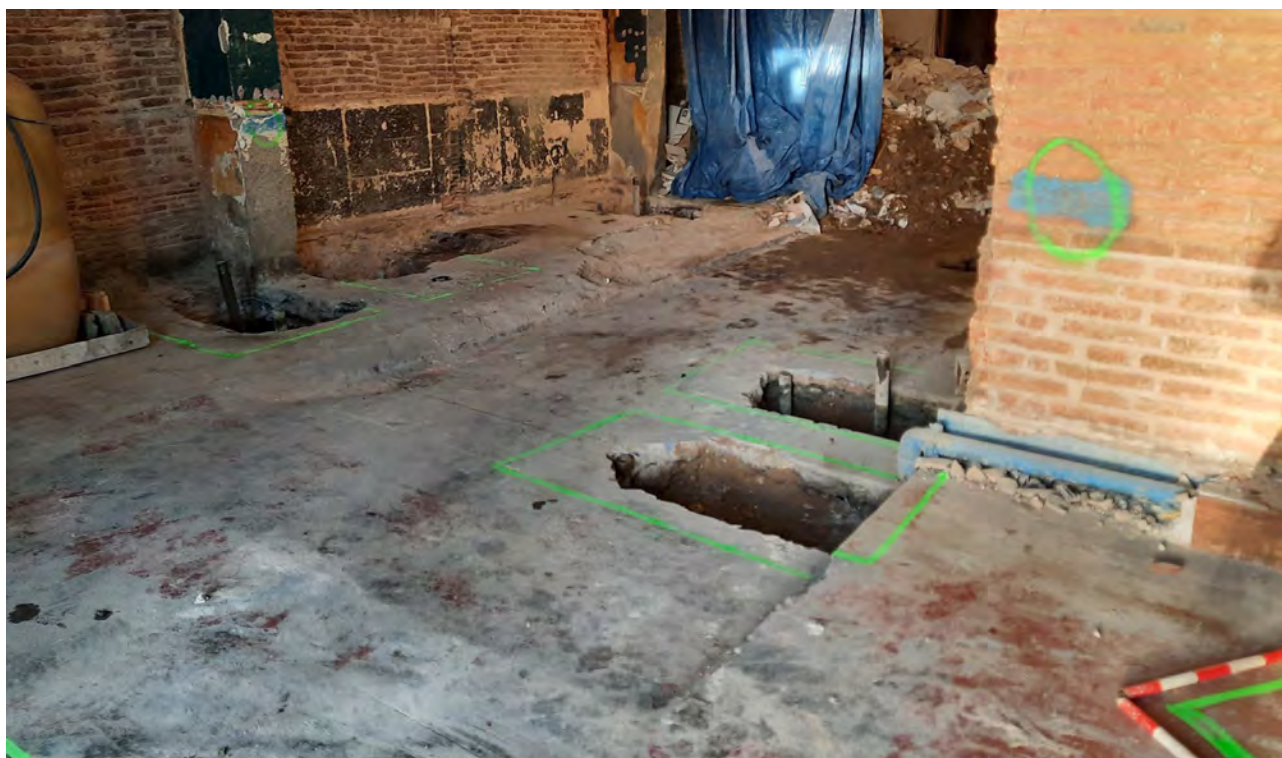
Imatge general de l'estat inicial del Sector Interior Colom Esquerre, previ a la nostra intervenció. Es poden veure els fonaments iniciats amb els micropilons clavats i runa al fons procedent dels enderroc de l'obra. 28/GEN/2021 (E. Píriz).
